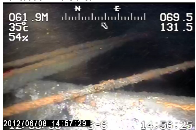
船裡管路是否漏油
